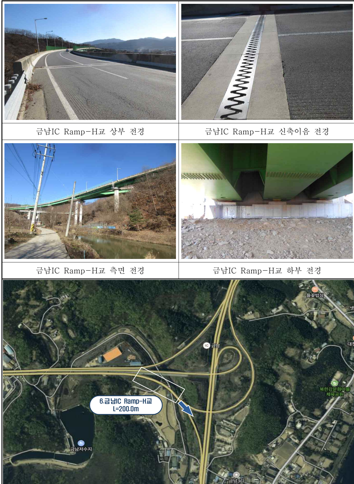
<그림 1.5> 금남IC Ramp-H교 전경사진
