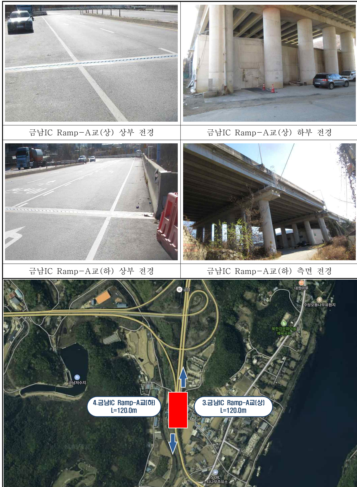
<그림 1.3> 금남IC Ramp-A교(상, 하) 전경사진
